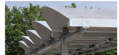
Kohlenstoffbewehrter Beton heute: dünnwandige gekrümmte Tonnenschalen als Dachelemente bei ITA
