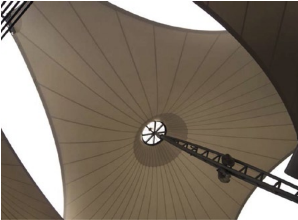
用于膜建筑的化学和热稳定纤维
